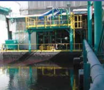
**El uso de un separador LAKOS como parte de su sistema de enfriamiento de procesos minimiza la acumulación de sólidos que normalmente se depositan en sumideros y estanques. Como resultado:**
