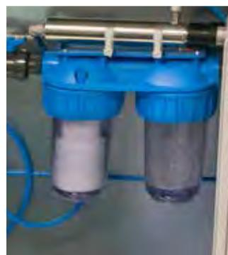
Detalle del sistema de filtración y desbacterización del agua
